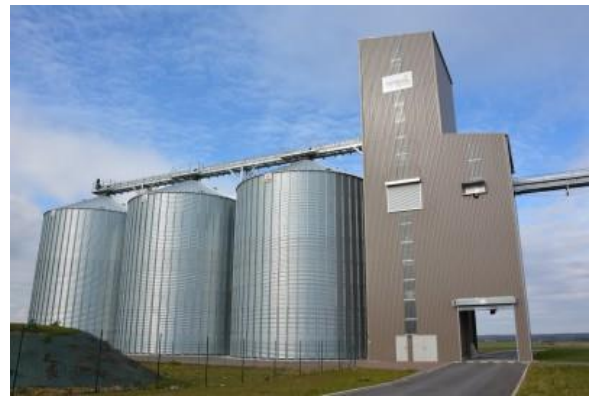
Silo Terrena à Saint-Léger de Montbrillais (86)
